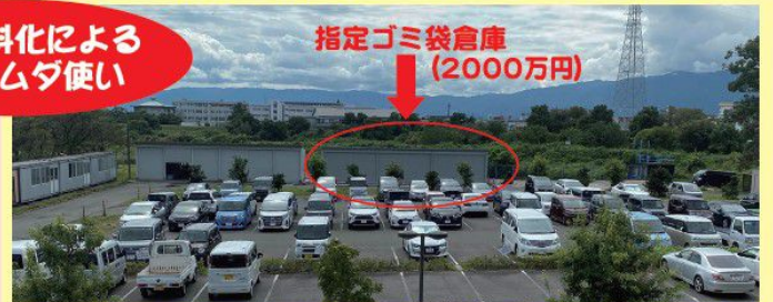
▲クリーンセンター2階から撮影（2022年9月9日）（米野町）ゴミ袋倉庫は完成しています。
